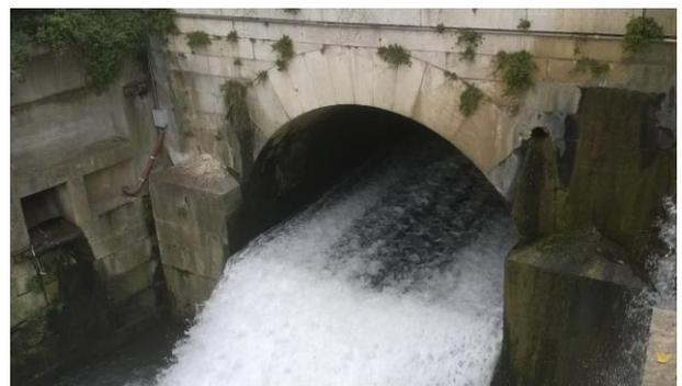
più ampio degli altri due, regola lo scarico delle acque nel Vigenzone – da cui il nome all’intera struttura - , mentre l’acqua che esce da quelli laterali era utilizzata per fornire energia agli opifici.
