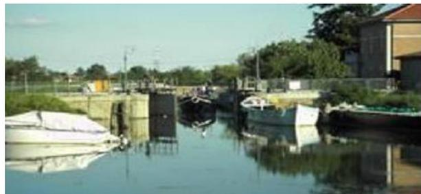
la sola pressione dell’acqua, mediante valvole ad aria compressa. La conca, costruita per imbarcazioni non superiori alle 300 tonnellate, misura 40 metri di lunghezza, 7 di larghezza e 10 di altezza. Le due porte a monte e a valle, pesanti fino a 30 tonnellate, anziché gravare sui cardini inferiori sono sospese mediante dispositivi con cuscinetti a sfere.
